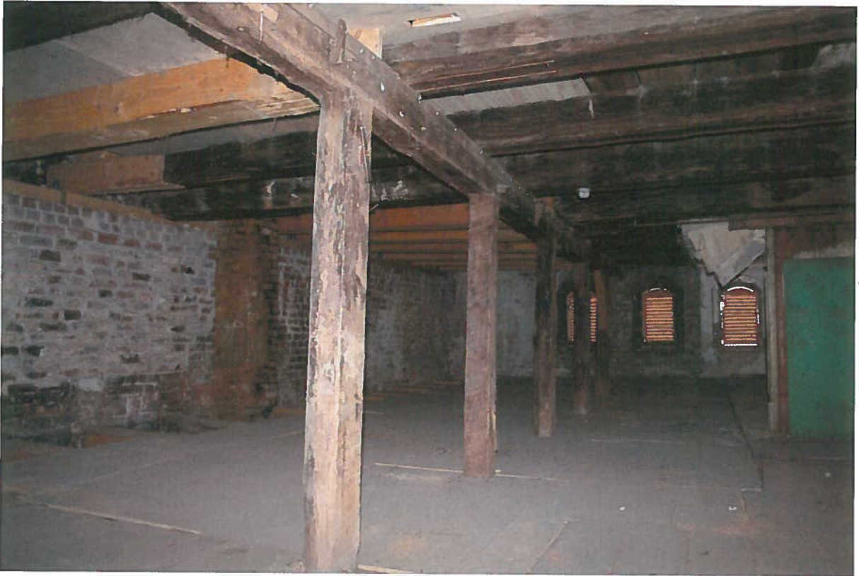
Abb. 4: Blick in ein Speichergeschoss im Dach
