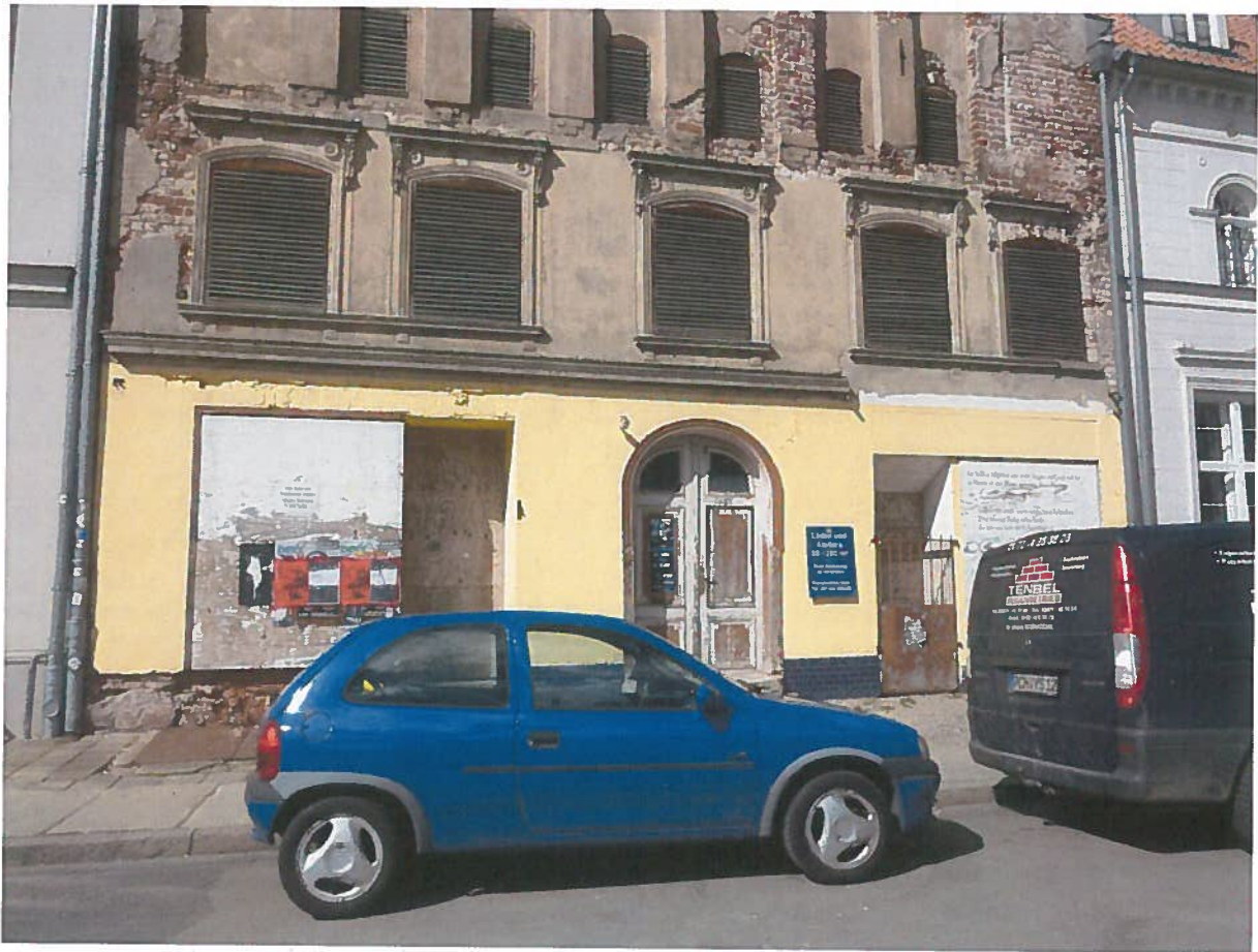
Abb. 2: Fassade zur Baderstraße (teilw.)
