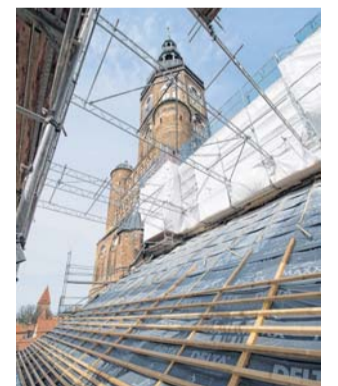
Der Greifswalder Dom wird restauriert. FOTO: STEFAN SAUER
